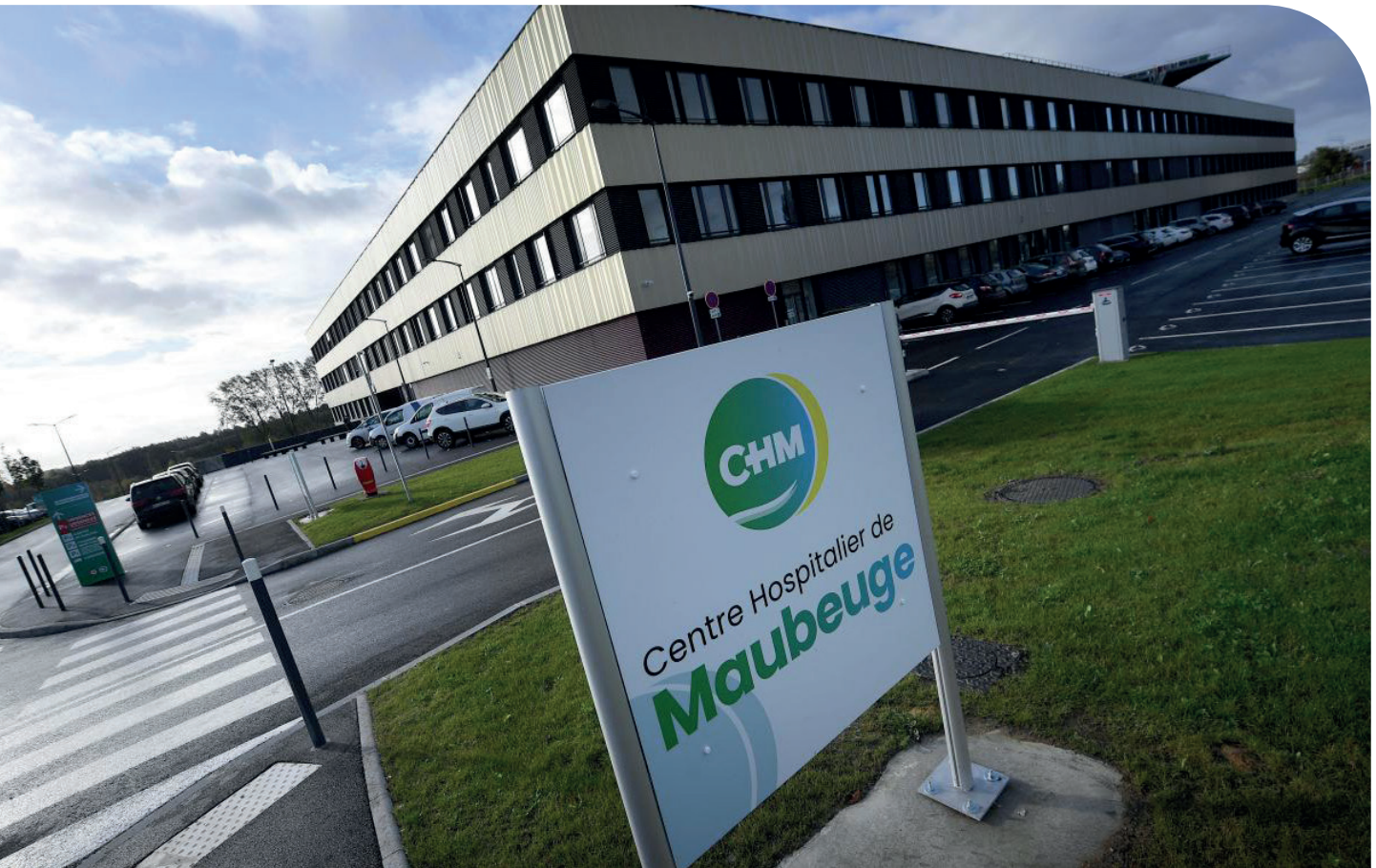
Neues Krankenhauszentrum, Maubeuge, Frankreich
