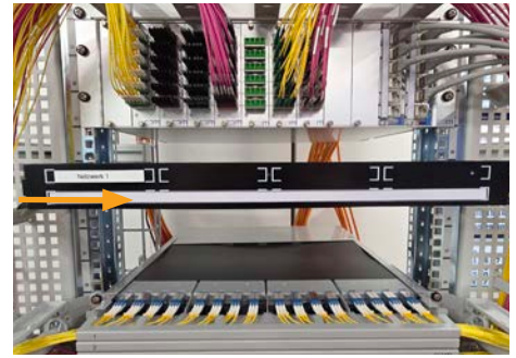
Streifen und Schutzhülle reinschieben Glisser la bande et le protège-bande
