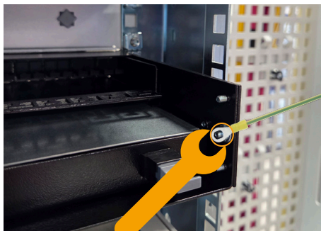
Erdungskabel für Träger und Rack bauseits
