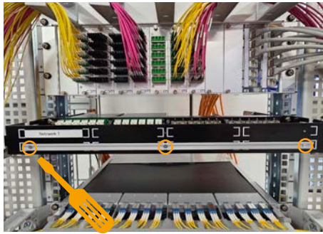
Befestigung Bezeichnungstreifen Fixation de la bande d'identification
