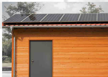
Avec photovoltaïque intégré
