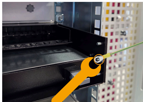
Erdungskabel für Träger und Rack bauseits
