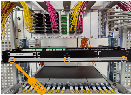
Befestigung Bezeichnungstreifen Fixation de la bande d'identification
