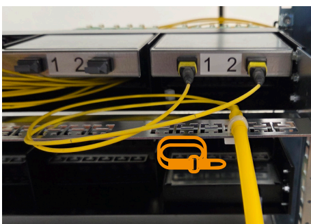
Befestigung Kabel Abfangung (optional)
