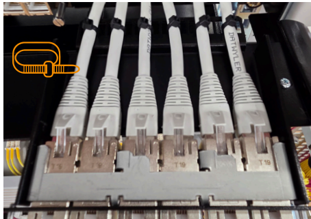
Befestigung Kabel CU-Module Fixation des câbles des modules cuivre
