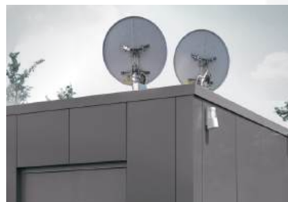
Mit montierter Richtfunkantenne
