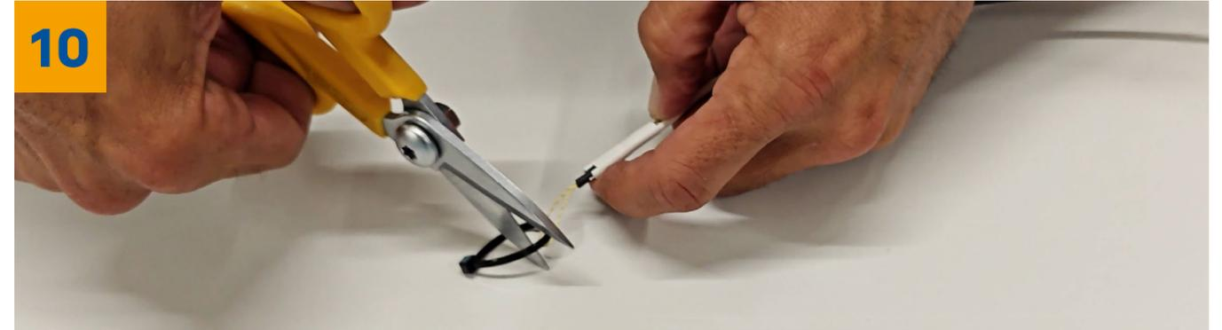
Nach dem Einzug werden das Klebeband und der Kabelbinder wieder vom Kevlar entfernt.
